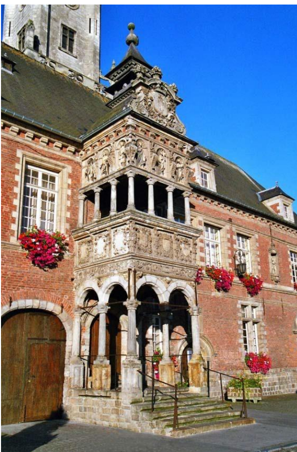
Détail de l'entrée principale de l'Hôtel de ville de Hesdin
