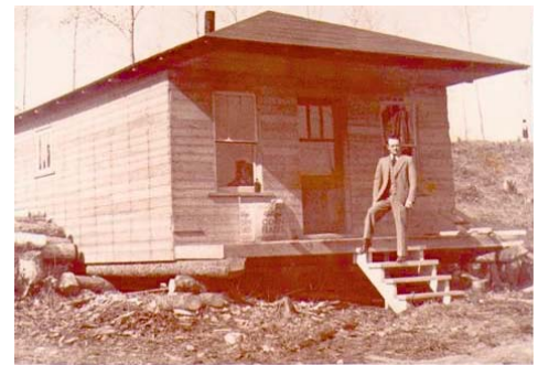
Le petit shack en bois taillé en partie au godard et à la hache.
