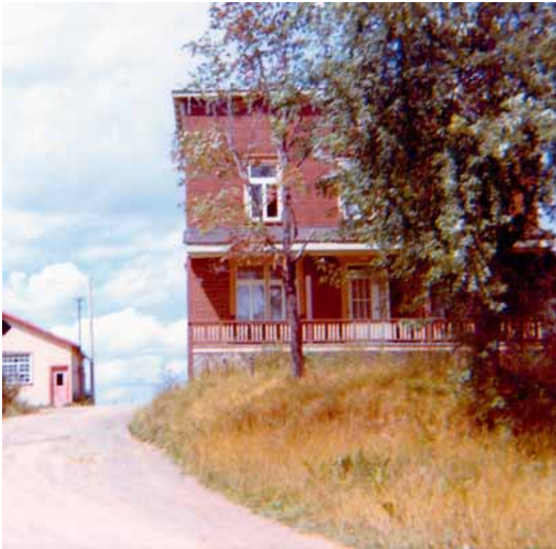
Maison où a été élevé David Jr. Cette maison, située sur un promontoire, a été construite en 1906 et démolie en 1974-1975
