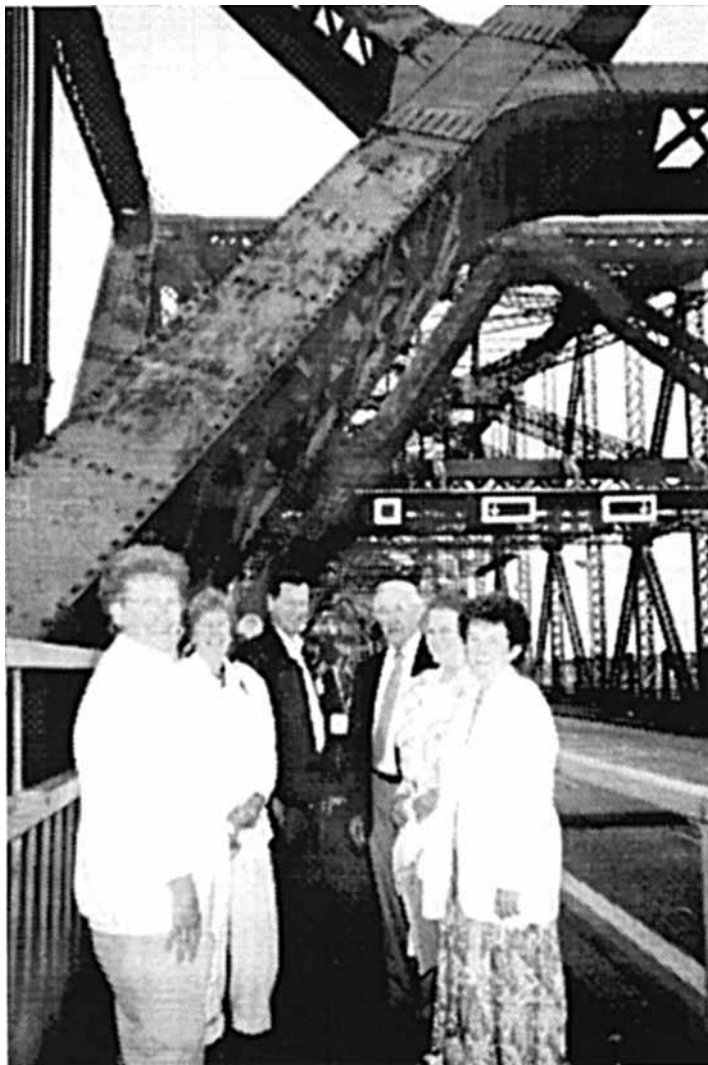
Visite du Pont de Québec : au milieu du pont tout rouillé et en voie d'être enfin rénové, Rollande, Cécile, René, Noël, son épouse et Claire.
