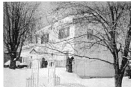
Maison familiale où Henriette a été élevée. La partie droite avait servi pour héberger les ouvriers lors de la construction du pont de Québec. Le père d'Henriette l'avait achetée, démontée, transportée à Cap-Rouge et rebâtie. Cette maison a été détruite il y a deux ans pour permettre un développement de condominiums
